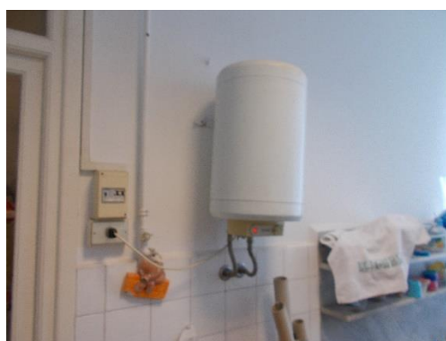
Figura 4.9 - Particolare di boiler elettrico per la produzione di acqua calda sanitaria
